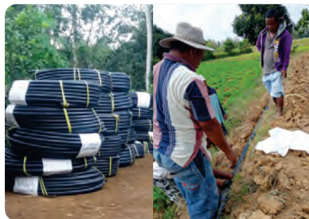
Trilliunprime @Proyek PDAM, Bangkalan, Madura (Jatim)
