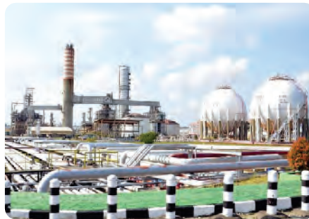
Trilliunprime @Proyek Kilang Pertamina, Balikpapan (Kaltim)
