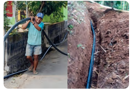
Trilliunprime @Proyek PAMSIMAS, Kec. Wado, Sumedang (Jabar)
