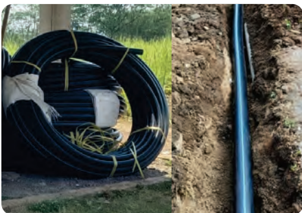
Trilliunprime @Proyek SPAM desa Kec. Ruteng, Kab. Manggarai (NTT)
